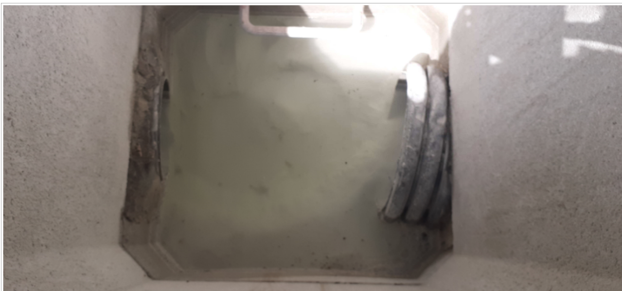
Traces de rejets de particules fines blanchâtres vers l'exutoire
