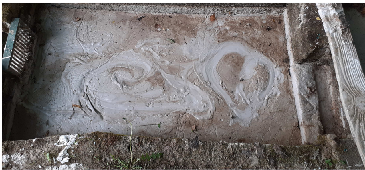
Boues de laitage de béton piégées dans le dégrilleur en aval de l'étang vers le ruisseau
