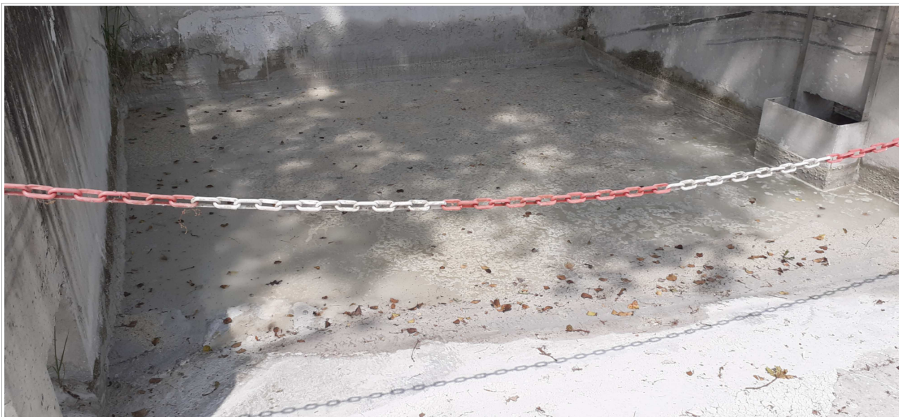
Bassin de décantation des eaux avant rejet
